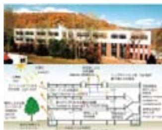
シンプルな建物形状による外壁面積の削減、外断熱、高断熱サッシの採用による外皮の熱性能の向上
