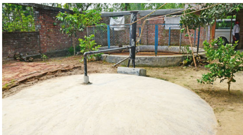
Setiap unit sarana produksi biogas berkapasitas 130 m 3 dapat menghasilkan 14 m 3 biogas dan 1,5 ton pupuk kandang.
